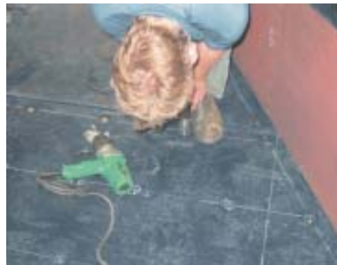
Fijación del revestimiento
