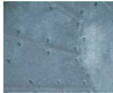
Costuras del revestimiento soldadas
