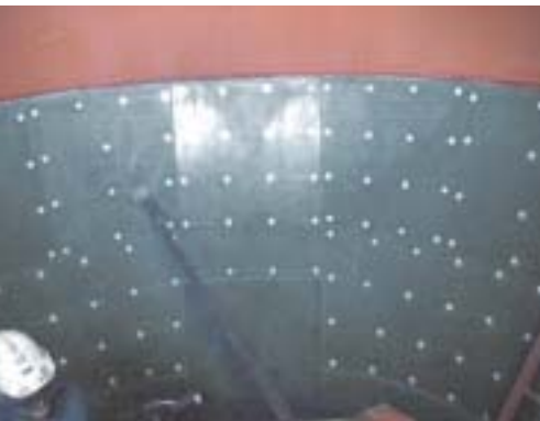
Instalación del revestimiento separate silo
