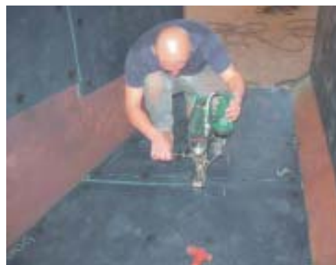
Técnica especial de soldadura para costuras
